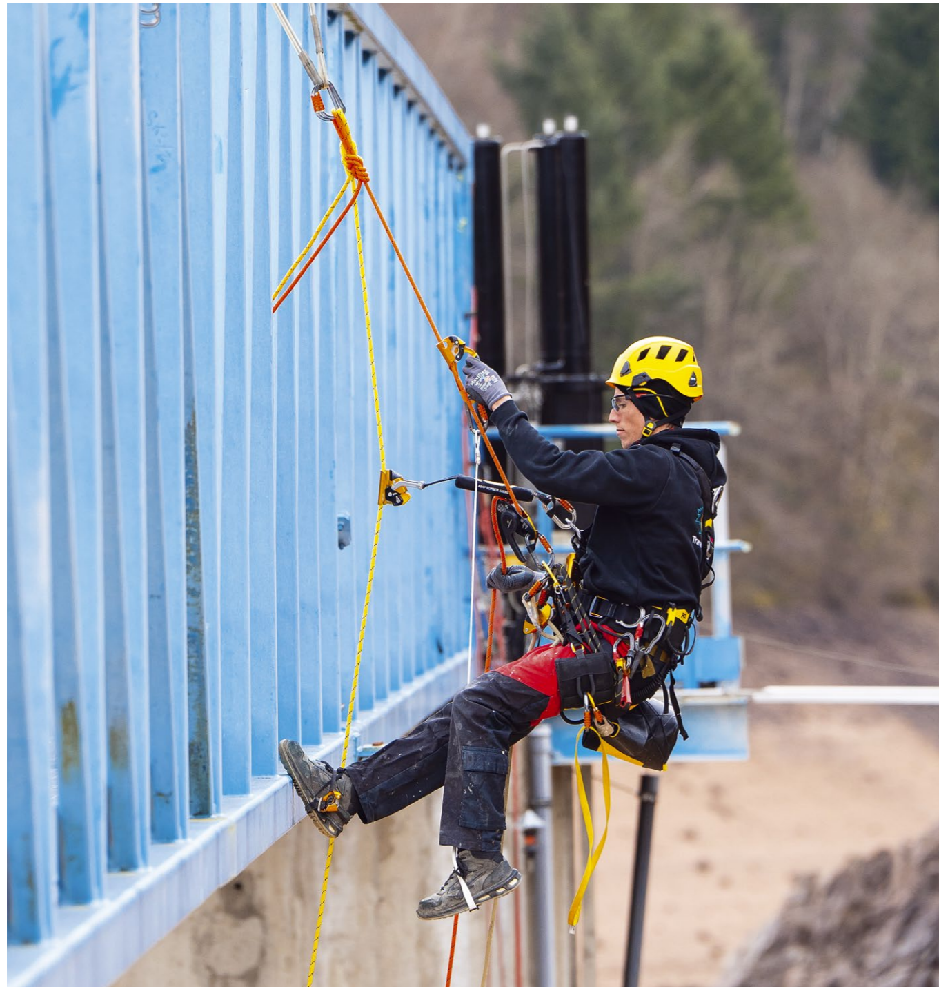
Rope access work on Barrage du Rouchain, France. © 2025 Petzl Distribution - Vuedici.org - Moretton Travaux Acrobatiques - Roannaise de l'eau
